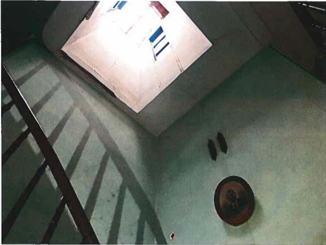
photographie 8 aperçu cage d'escalier
