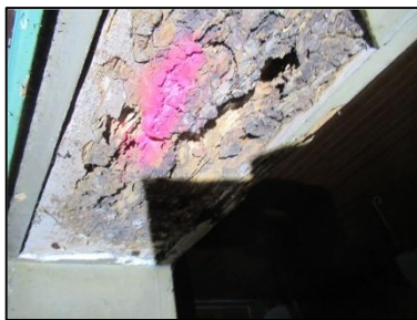
Traces d'attaque de termites souterrains
