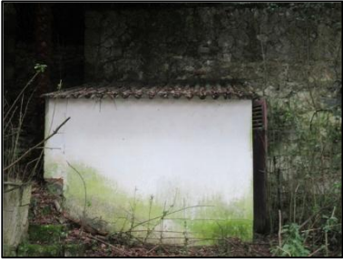
Photo N° 001 -Rdc-DEP-pièce 4_Rdc_DEP-Couverture-Plaques ondulées (Fibres-ciment)
