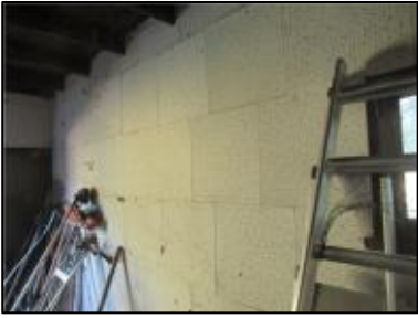
Photo N° 001 -Rdc-Garage_Rdc- Murs-Dalle 60x60
