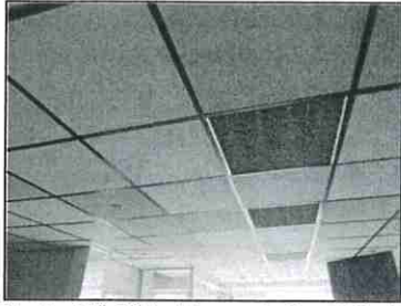
Photo N° 001 -Faux plafond-Dalle 60x60
