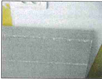
Photo N° 002 -Rdc-Magasin_Rdc- Faux plafond-Dalle 60x60
